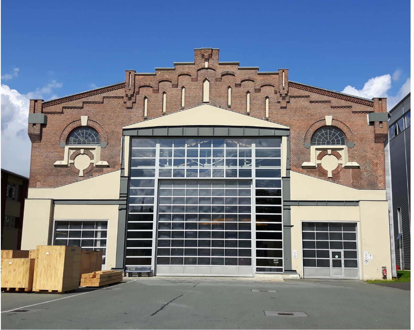
Außenansicht des Turbinenwerks Görlitz Exterior view of the Görlitz Turbine Factory
